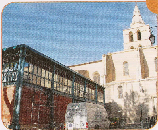
Travaux d'entretien en coeur de ville
